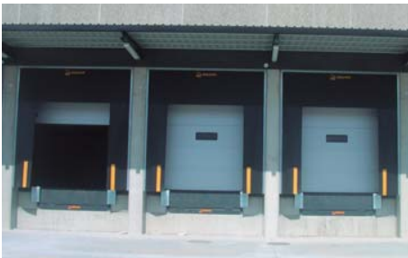
Abrigo ras de fachada
