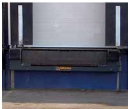
Mini rampe dans un quai de chargement.
