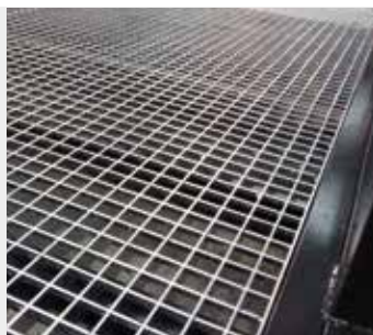
Superficie de la rampe.
