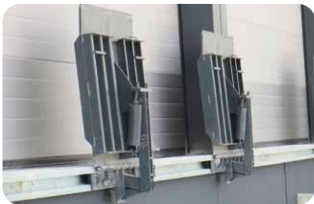
Passerelles PA1 installées fixe sur le quai de chargement.
