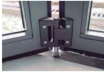
Dispositivo de bloqueo de la puerta.
