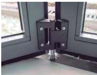
Dispositivo de bloqueo de la puerta.
