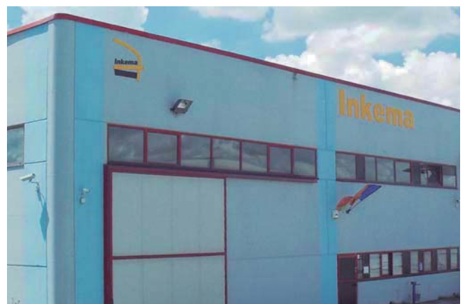
Fábrica y almacén en Timisoara (Rumanía)
