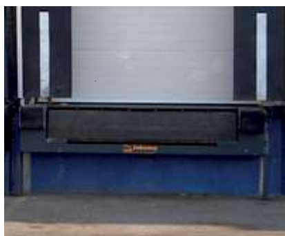
Mini rampe dans un quai de chargement.
