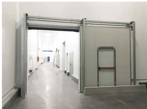
Plaque guidée par la partie inférieure au moyen d'un rouleau d'accompagnement.
