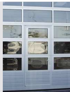
Porte piétonne vitrée
