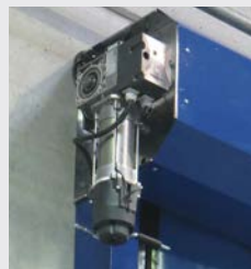
Motor reductor acoplado al bastidor de la puerta
