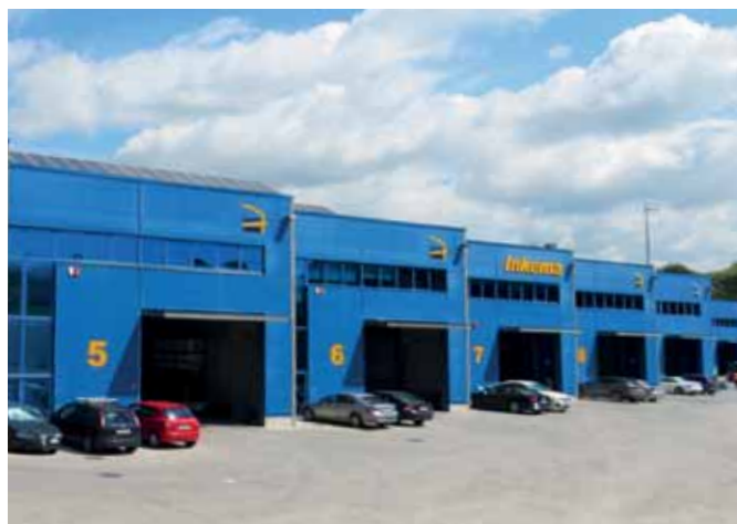
Siège et usine à Parets del Vallès (Barcelone – Espagne).
