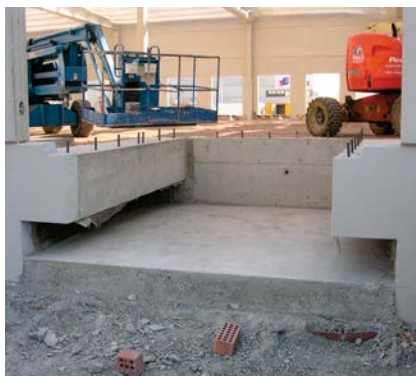
Modelo de foso para rampas autoportantes
