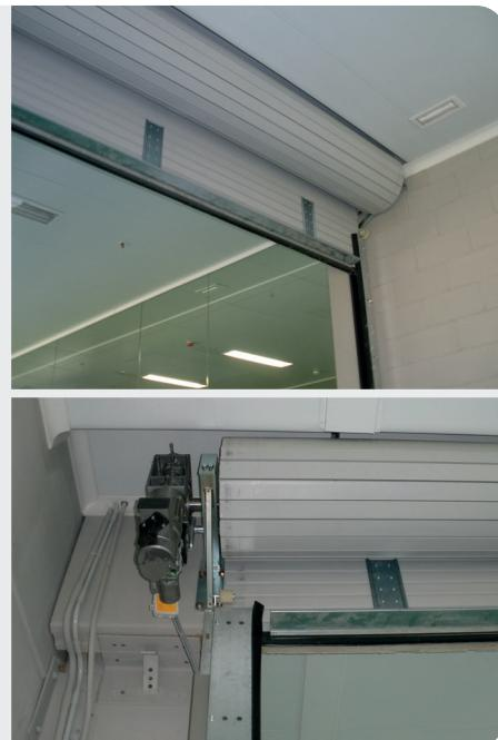
La **Puerta cortafuego enrollable RFENR de Inkema** se ha diseñado y calculado de acuerdo con las siguientes directivas y normativas Europeas: **UNE EN 1634-1y UNE EN 1363-1**.
