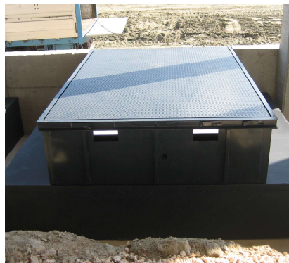
Fosse pour RH22/RH32 avec coffrage (en option)
