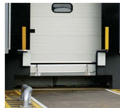
Vue extérieure d'un niveleur installé RH22/RH32
